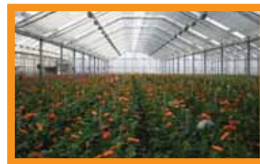
Heizung für Gewächshäuser
